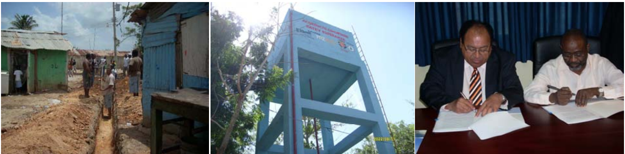
Construcción de zanjas para colocar los tubos para la distribución de agua, firma de convenio entre el director de INAPA ingeniero Frank Rodríguez, y el señor Antonio Florián, Director Ejecutivo del IDAC, tanque elevado de almacenamiento de agua, en el marco del proyecto
